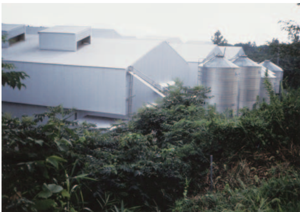
コンピューターで環境制御された採卵鶏舎（1棟5万羽収容、3棟15万羽を1人で管理する。円筒型のサイロは飼料タンク） （所在地：茨城県）
